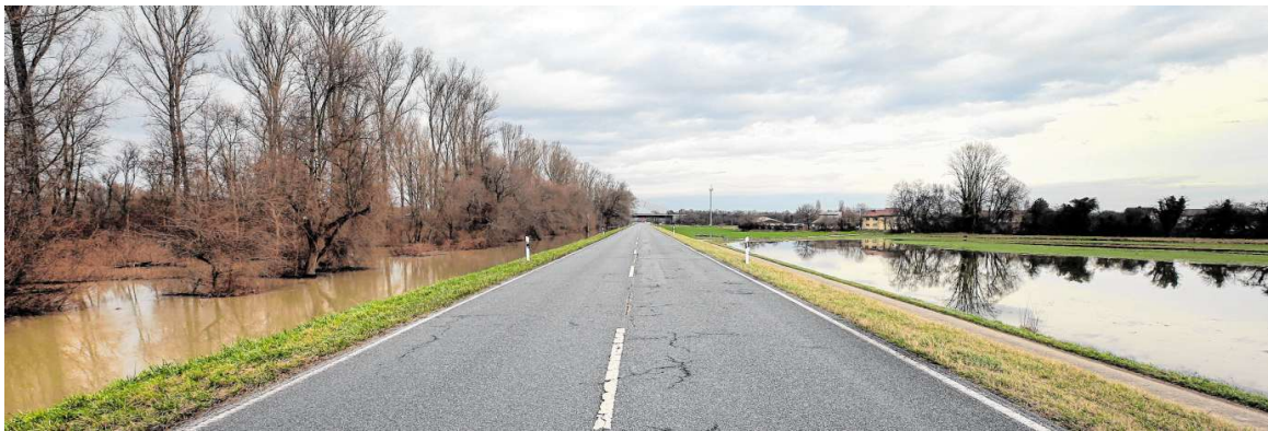
Das Druckwasser steht schon auf den Feldern (r.) und hat einige Keller der Aussiedlerhöfe (rechts im Hintergrund) bereits geflutet. Jetzt hoffen die Landwirte, dass es rasch wieder abfließt.
